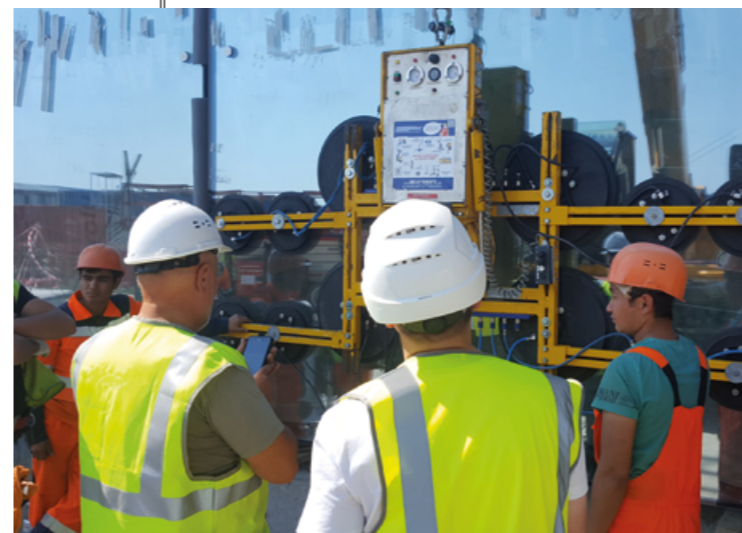
Инструктаж на месте: вакуумная установка VSG 1500 КН
