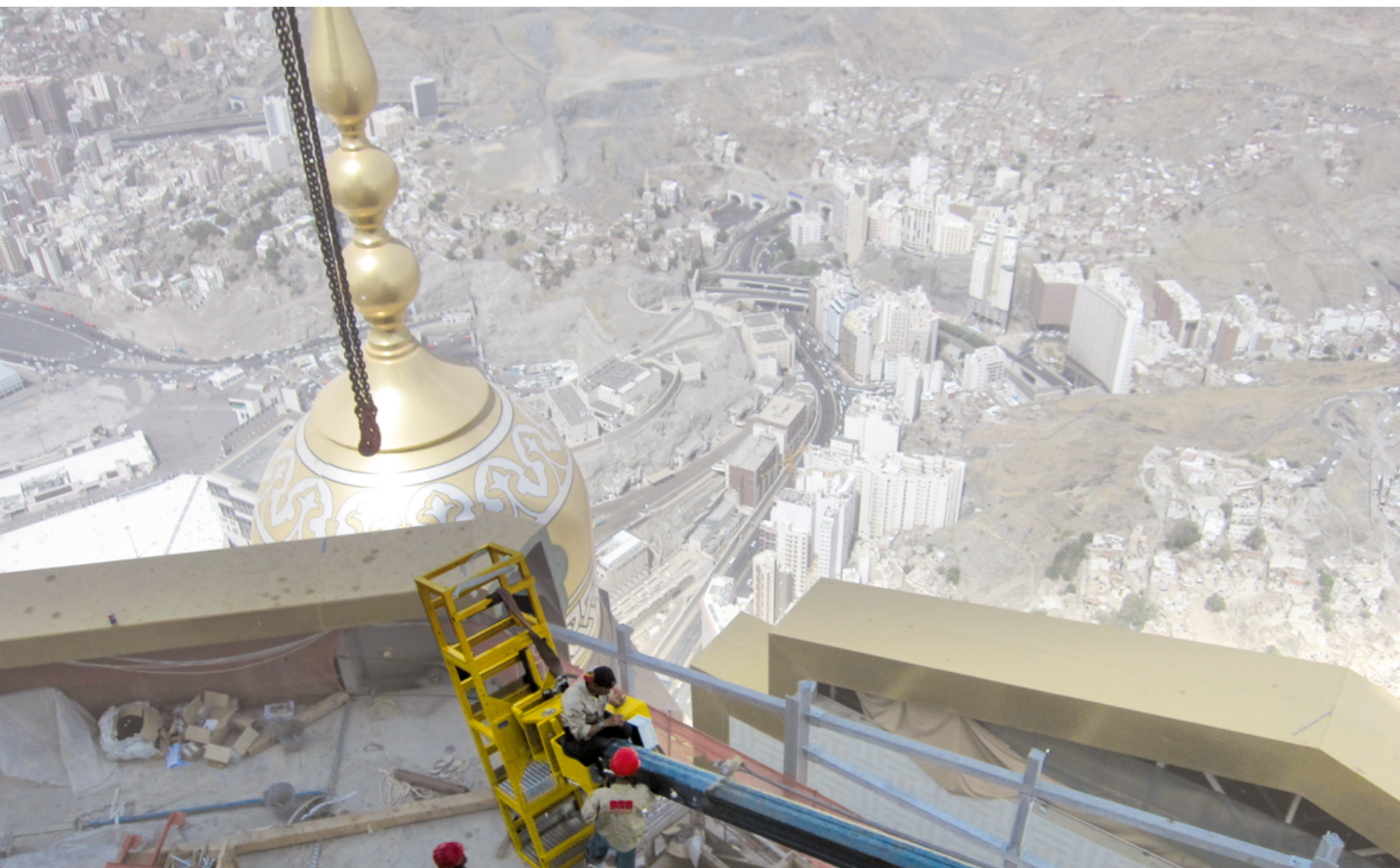
Рабочая корзина с вакуумным захватом
