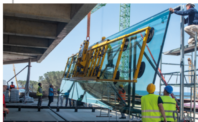
Вакуумная установка VSG 6000 KMH в процессе работы с 15-метровым стеклянным элементом
