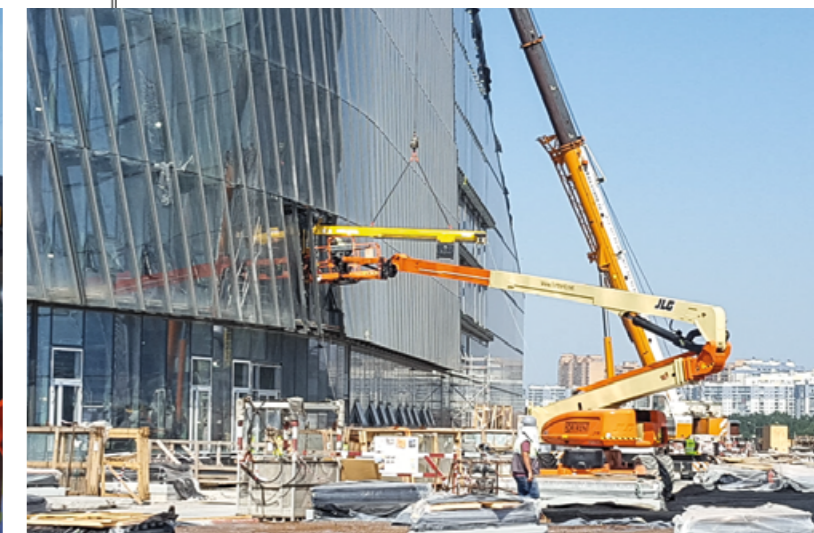
Специально разработанная траверса с противовесами в действии
