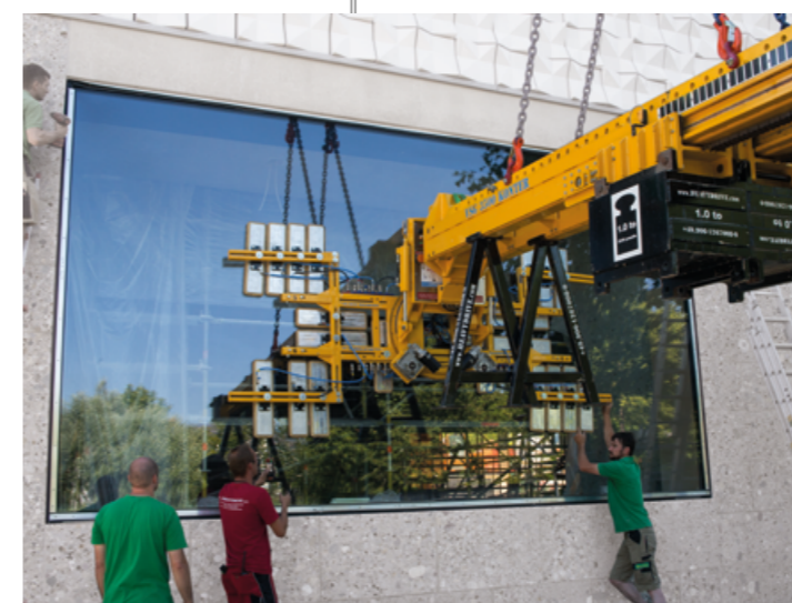
Точный монтаж стекол размера XXL
